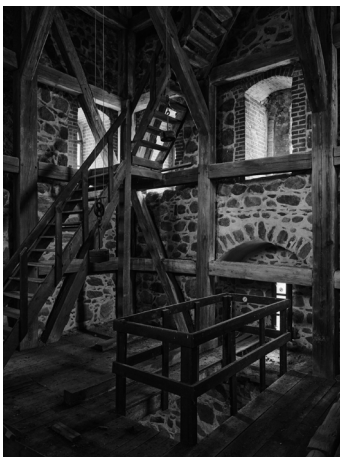
Wnętrze wieży kościoła w Moryniu. Fot. A. Pukalski, 2025
